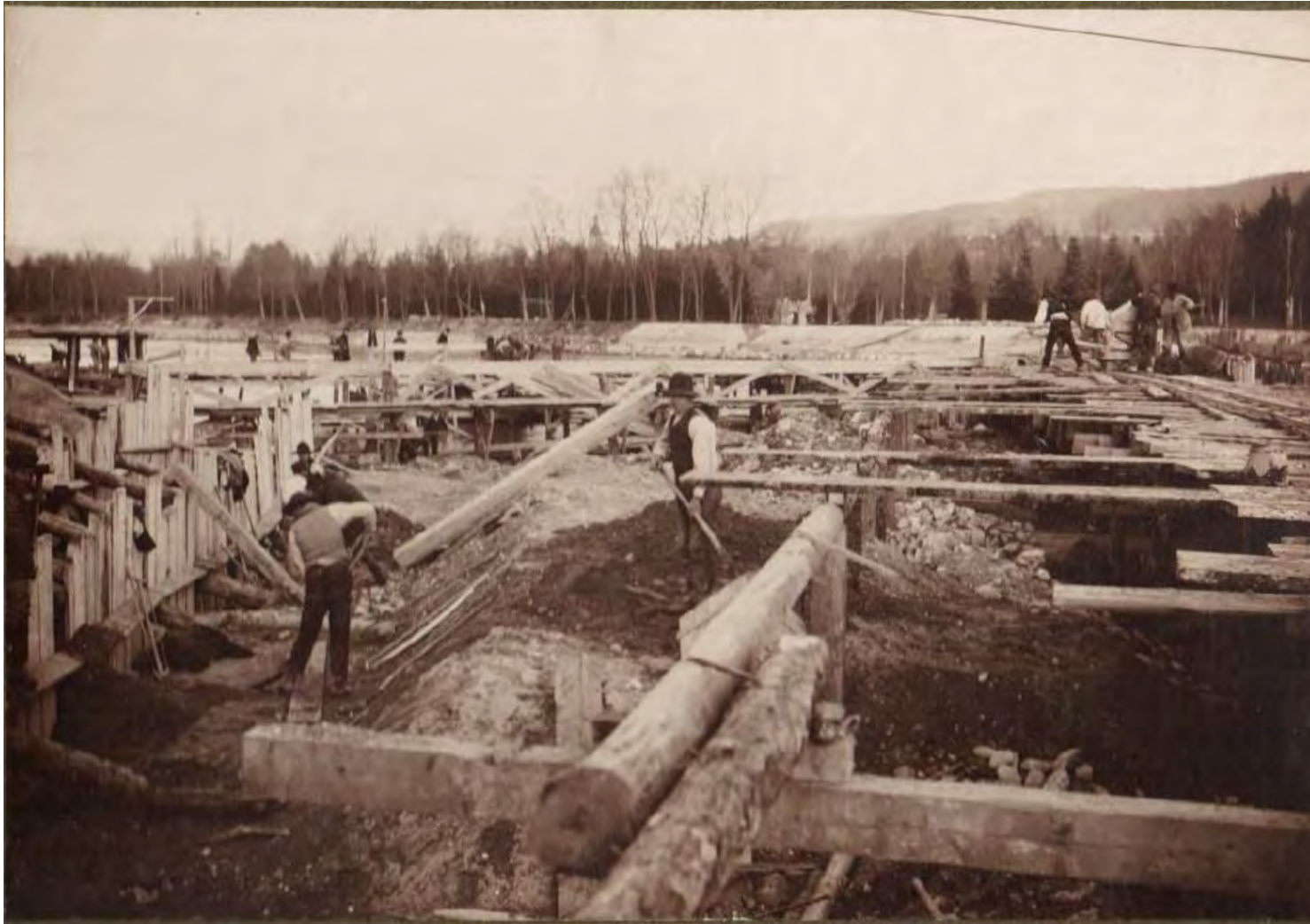
Bildserie über den Bau des Betonwehrs 1906 Originallegende: Stauwehr Schönenwerd
