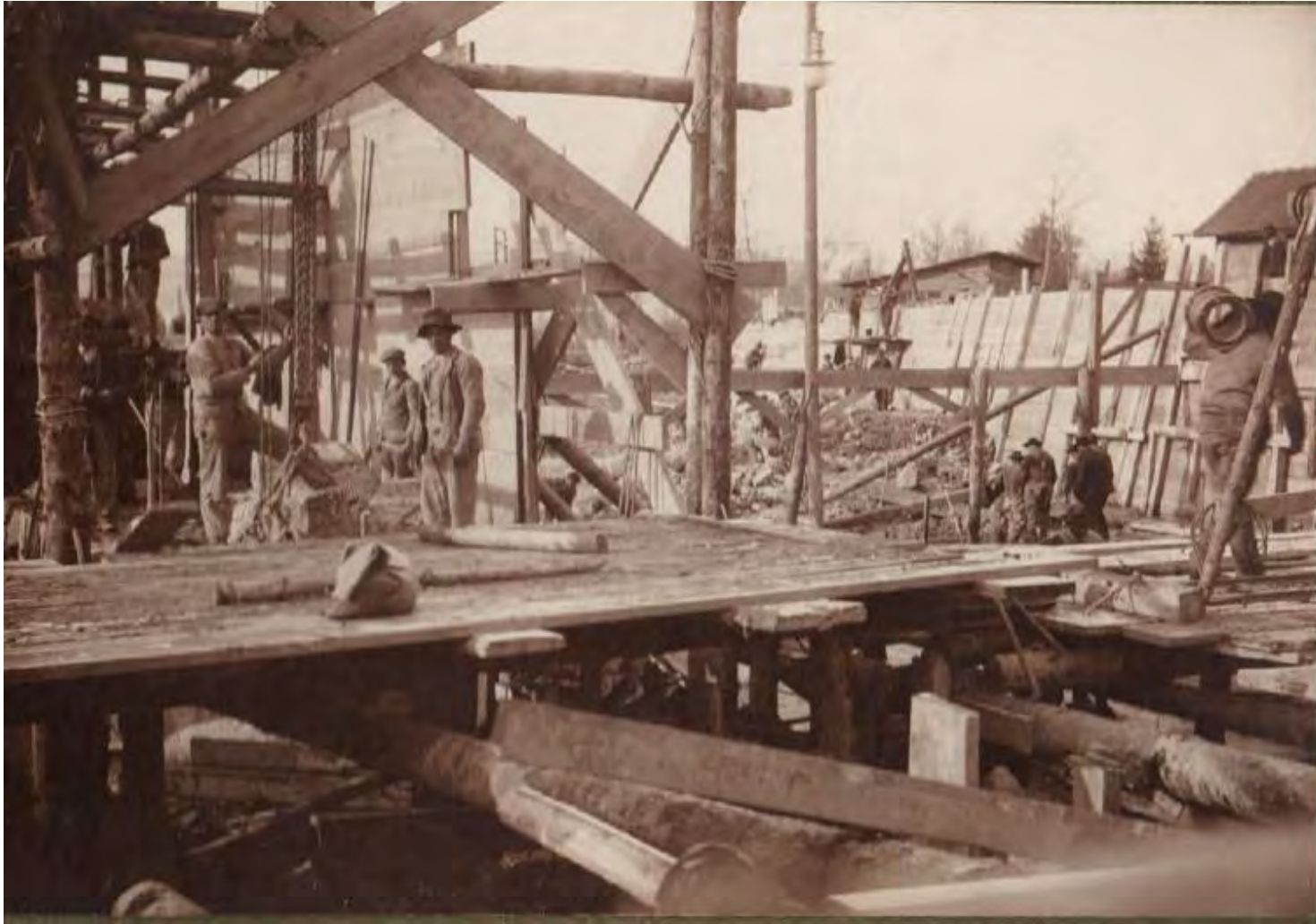
Bildserie über den Bau des Betonwehrs 1906 Originallegende: Arbeiten für den Stauwehrpfeiler am Gösger-Ufer
