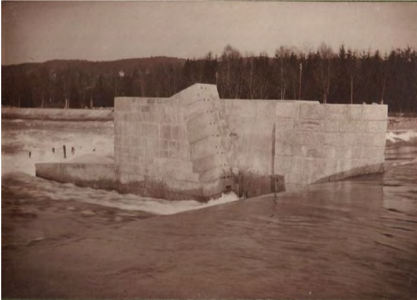
Bildserie über den Bau des Betonwehrs 1906 Originallegende: Der fertige Pfeiler
